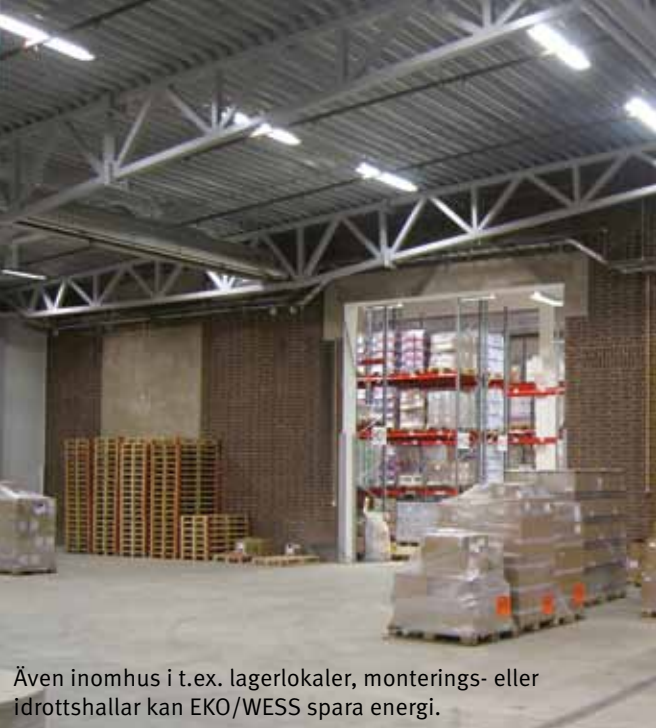
Låt en rörelsedetektor styra effektnivån i belysningen, då ökas ljusstyrkan när det verkligen behövs.
